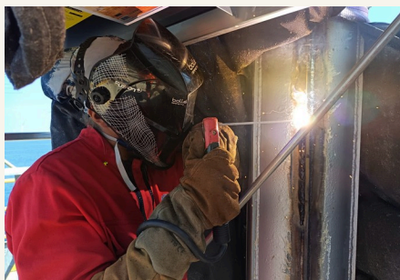
■ SOUDURE SUR UNE FONDATION D'ÉOLIENNE EN MER
